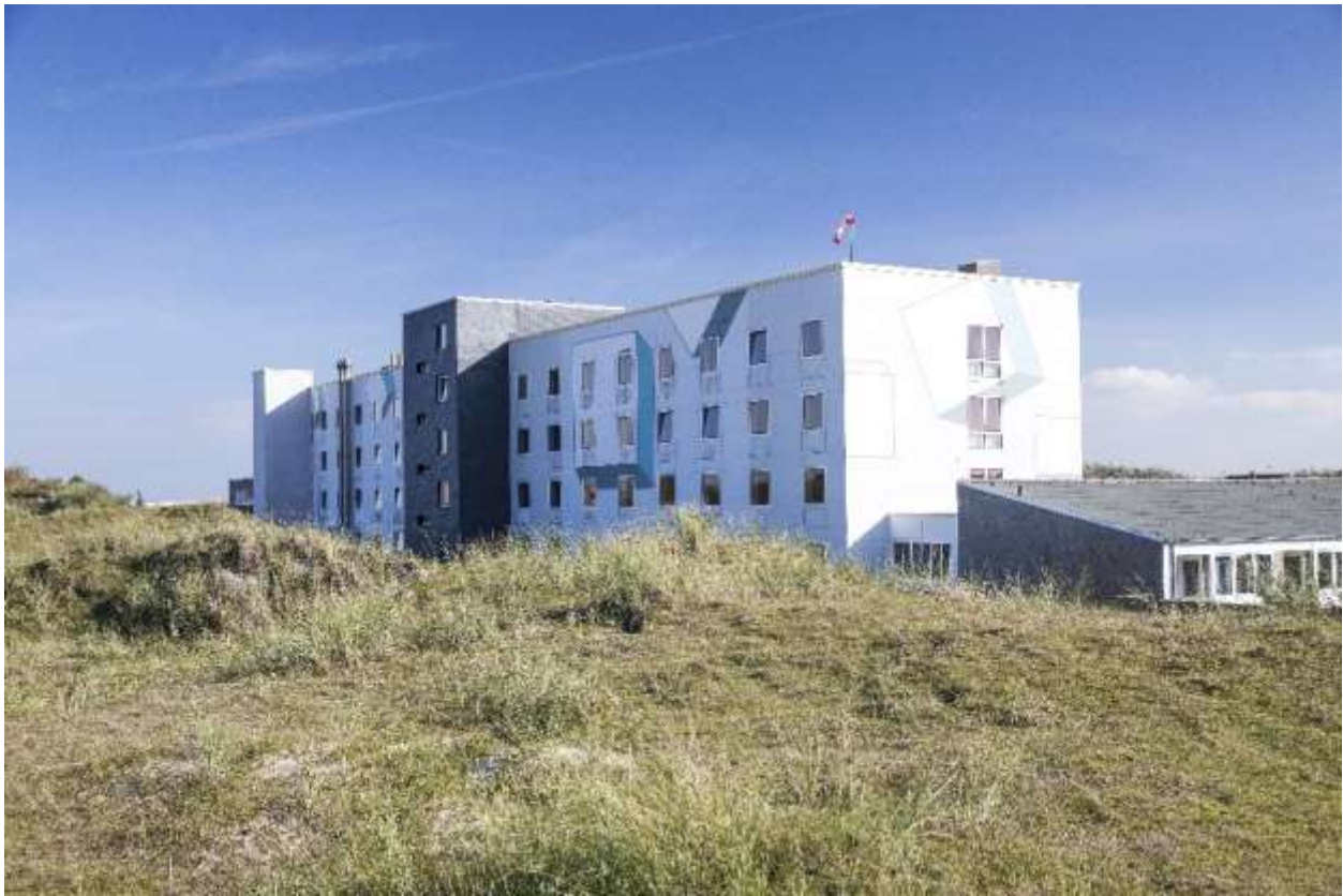
Der Blick aus den Dünen auf das Hauptgebäude. Das Bild zeigt die Meerseite.
